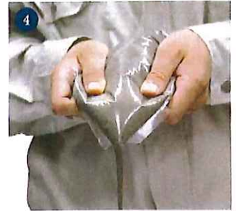
④ パックの切り込み部をカットして グラウトモルタルを押し出します。
